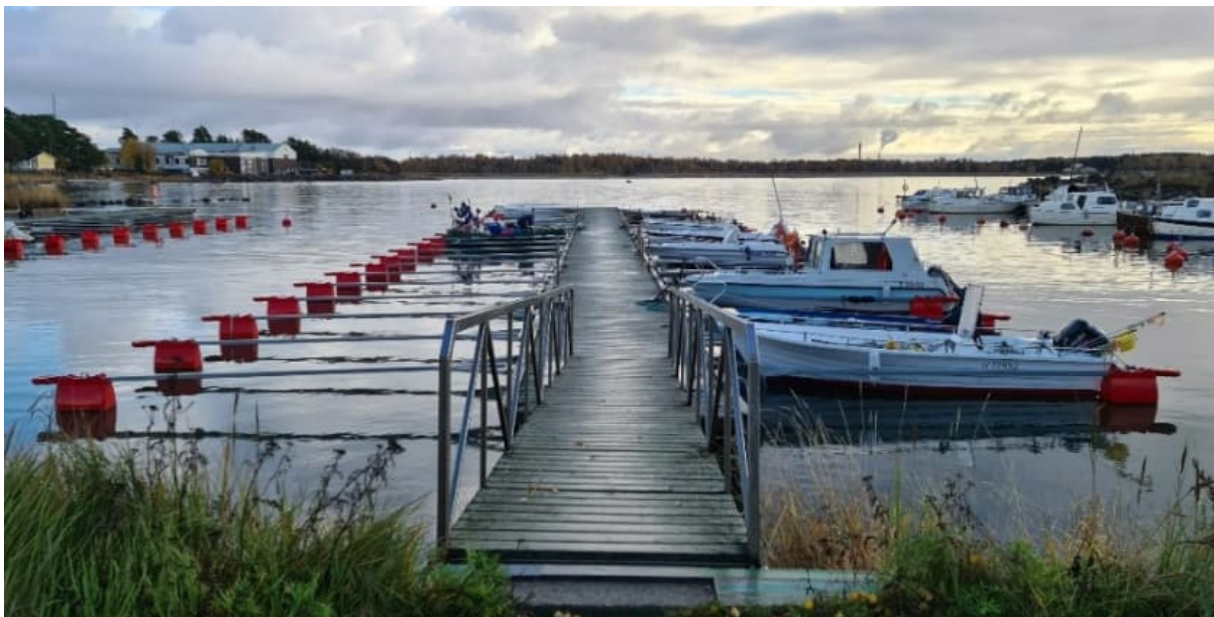
Kuva 5-29. Uniluodon keskimmäinen laituri (Hakanen, 2021).
